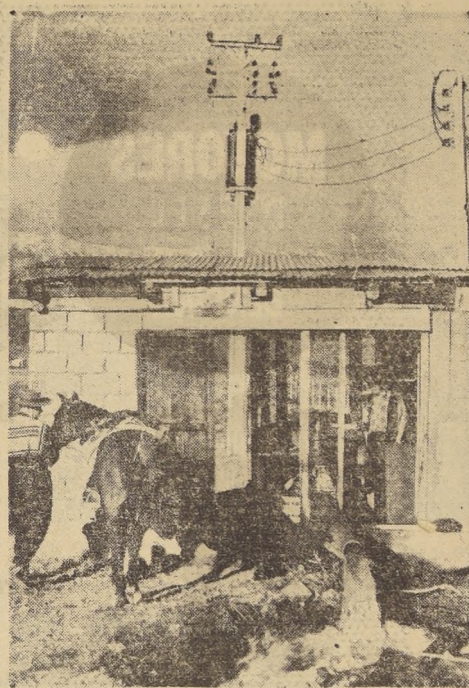
Esta bomba vertical de pozo profundo, instalada en un predio de la zona central, ha permitido al agricultor que hizo la inversión, triplicar su producción de chacarera. Nótese que esta bomba está provista de un motor eléctrico, ya que está en la zona electrificada, al norte de Santiago. Sin embargo, las bombas verticales de pozo profundo también están provistas de un caballo para hacerlas funcionar con una correa y mediante un tractor o motor de cualquiera otra clase. El pozo de esta bomba tiene 66 metros de profundidad, y produce 70 litros de agua por segundo que son depositados en un tranque, para el regadío por canales.
