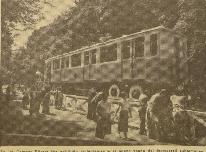
En los Campos Eliseos fue exhibido recientemente el nuevo vagón del ferrocarril subterráneo de París, al que se le ha reemplazado las ruedas metálicas por magnéticas. Esta innovación permitirá el funcionamiento totalmente silencioso del "metro", sin que ello signifique disminución del sistema de seguridad del convoy. Por el contrario, se dice que ofrece muchas ventajas técnicas sobre el sistema empleado hasta ahora.
