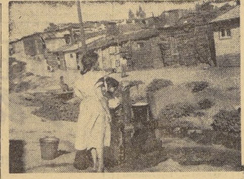
Esta es la única llave de agua potable de la Población Libertad, recorrida de charcas detestables. Al fondo, puede verse la aglomeración de viviendas. Tres manzanas incluye el conjunto, donde las casas se amontonan confundidamente sobre un suelo mojado por la humedad y los inmundos desagües.
