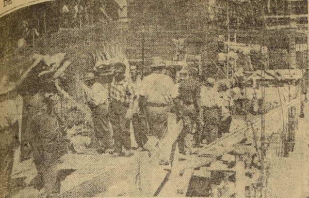
Trabajadores de la firma Francos y Friedman laboran en gran número en la construcción del Mercado Modelo. El grabado corresponde al frigorífico del nuevo Mercado y está ya terminado para empezar a concretar. (Foto de Fernando Lucero A. corresponsal.)
