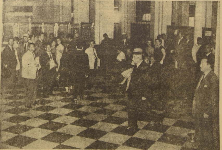
En este amplio hall central de la Caja de Empleados se encuentran distribuidas las secciones que tienen mayor afluencia de público, como son las oficinas de partes, las cajas pagadoras y receptoras las secciones de información sobre diferentes trámites de expedientes, etc. En la actualidad, se está poniendo fin a una serie de modificaciones internas que han hecho más expedito el movimiento del público, facilitando la atención de éste por los funcionarios de la Caja.
