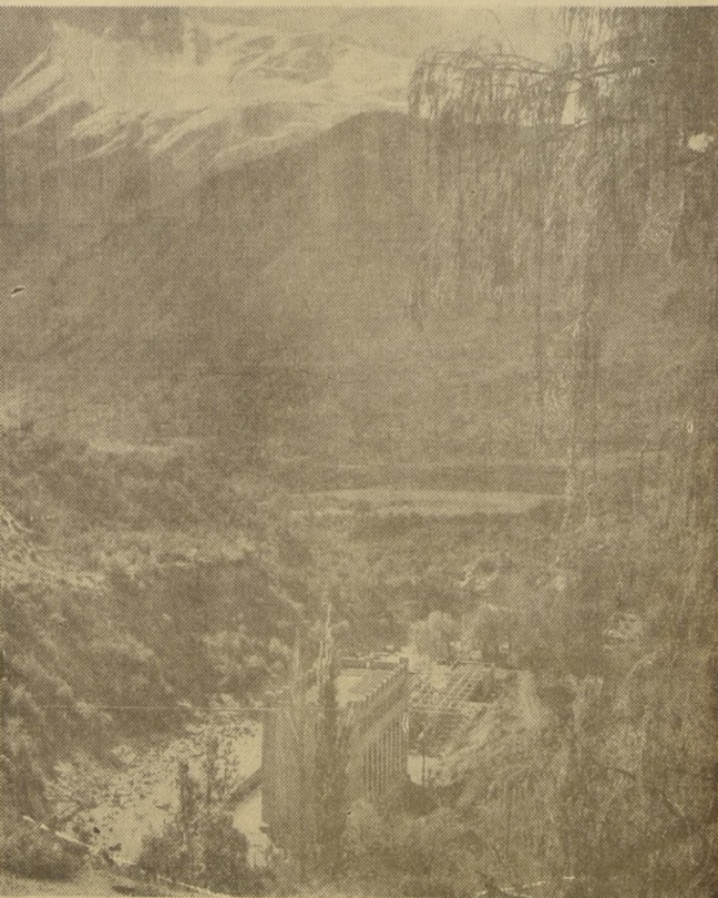
A 90 kilómetros de Santiago, enclavada en un hermoso rincón cordillerano, está la planta hidro-eléctrica de Queltehues, de la Compañía Chilena de Electricidad Ltda. La capacidad de producción de esta planta llega a 39.000 KW.
