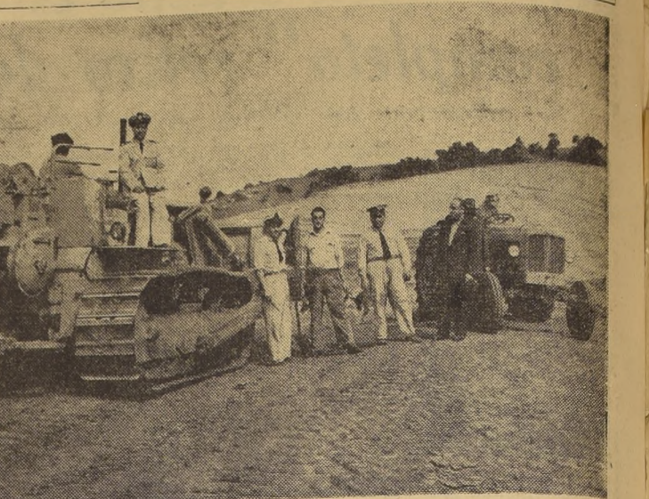
A SEIS MILLAS DEL CONTINENTE, frente al puerto militar de Talcahuano, había 466 hectáreas de terreno que se destinaron a la construcción de un establecimiento de cría de animales y el abastecimiento de leche. Los marinos han cooperado, como lo muestra la foto. Ahora se producirá leche y trigo, para abastecer la Escuela de Grumetes.
