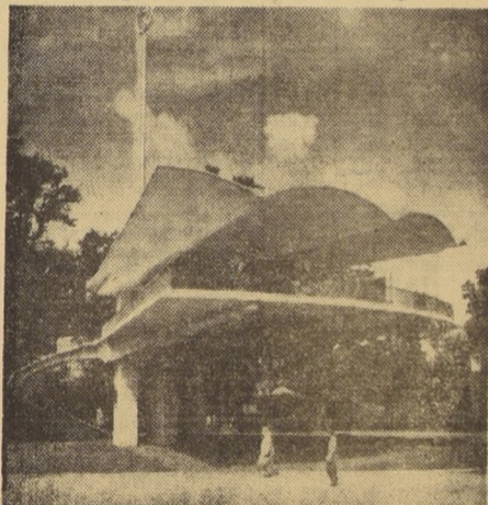
En el grabado, la famosa casa flotante construida en Hannover, Alemania, en una audaz concepción de la ingeniería moderna.
