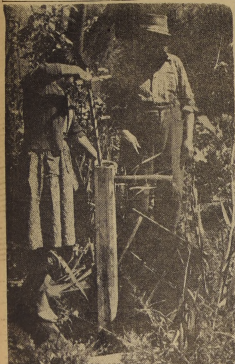
El programa de salubridad del Plan Chillán, ha permitido que los campesinos construyan sus pozos al amparo de peligrosas infecciones. El agua es extraída con bombas manuales.
