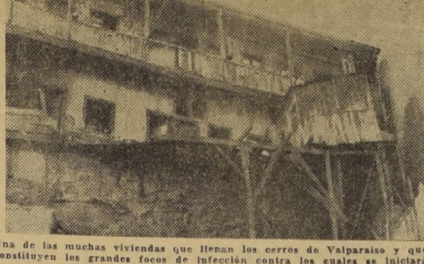
Una de las muchas viviendas que llenan los cerros de Valparaíso y que constituyen los grandes focos de infección contra los cuales se iniciará una energética campaña.
