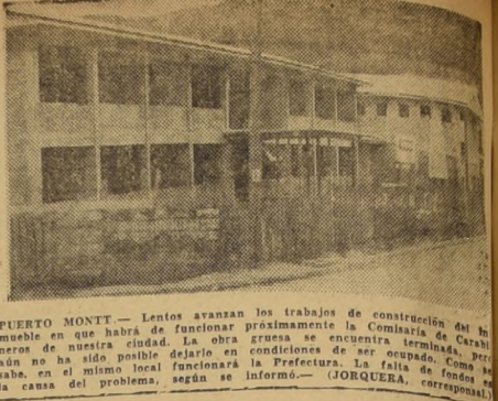
PUERTO MONTT.— Lentos avanzan los trabajos de construcción del mueble en que habrá de funcionar próximamente la Comisión de Carabineros de nuestra ciudad. La obra gruesa se encuentra terminada, pero aún no ha sido posible dejarla en condiciones de ser ocupada. Como se sabe, en el mismo local funcionará la Prefectura. La falta de fondos para la casa del problema, según se informó. (JORQUERA, correspondiente).
