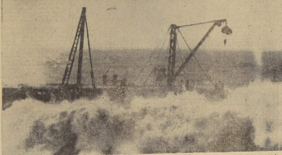
El muelle de los Astilleros de "Las Habas" cubiertos totalmente por las grandes olas que lo han azotado insistentemente.
