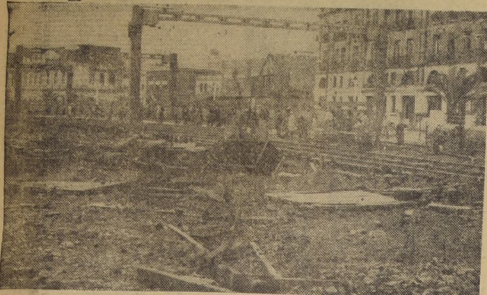
La Costanera, frente a la Avenida Errázuriz muestra fierros, restos de embarcaciones y hasta ruedas de vagones que el viento y el mar arrojaron hasta las mismas barandas que la separan de los recintos ferroviarios.
