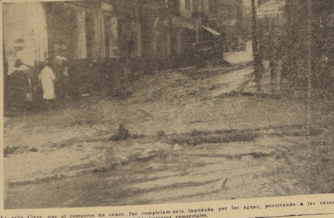
La calle Clave, que al romperse un canal, fue completamente inundada por las aguas, penetrando a las casas y establecimientos comerciales.
