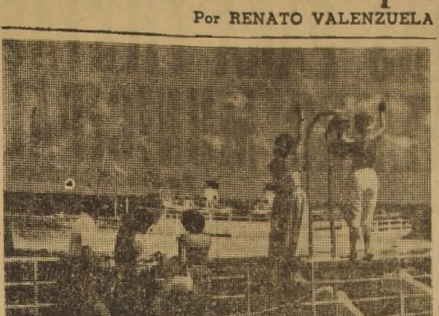
Desde la cubierta, los pasajeros saludan a los de otro barco que cruza el océano en dirección contraria.
