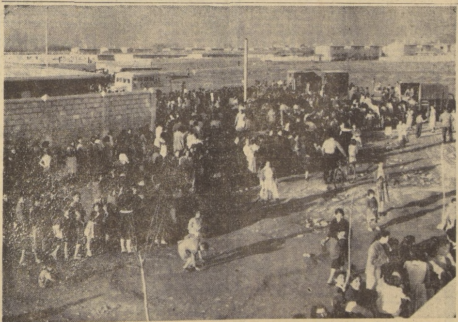
Cuatro colas, formadas por centenares de dueñas de casa, esperan, anhelantes, el turno que les corresponde para recibir un kilo de azúcar que les venden los puestos móviles de la SAP...
