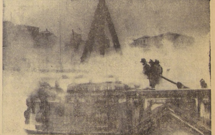
Espectacular fue el incendio que estalló en las primeras horas de la tarde de ayer en el último piso de la Bolsa de Corredores de Valparaíso en pleno "Wall Street" porteño, y en que el edificio perdió su característica cúpula que fue totalmente destruida por las llamas que afectaron también a los dos pisos superiores. El gran
