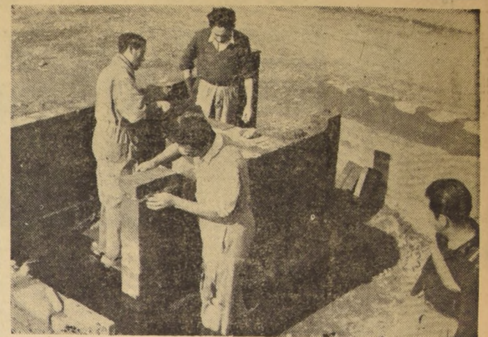
Obreros metalúrgicos ejecutan hábilmente la albañilería de la vivienda de uno de los miembros del grupo de trabajo. La su construcción está en marcha.
