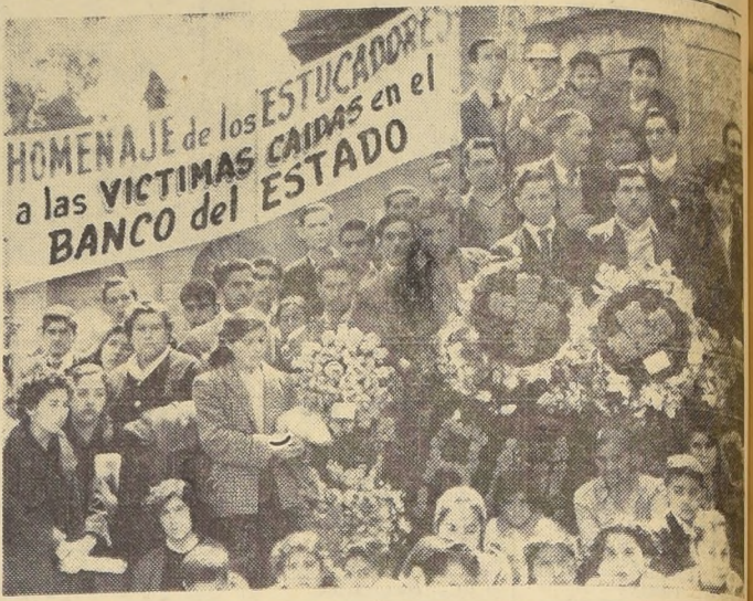
HOMENAJE A CAIDOS EN EL TRABAJO.— Cementerio General a rendir un homenaje a los obreros que el 26 de septiembre de 1952 perecieron trágicamente en el accidente ocurrido durante la construcción del actual edificio del Banco del Estado.
