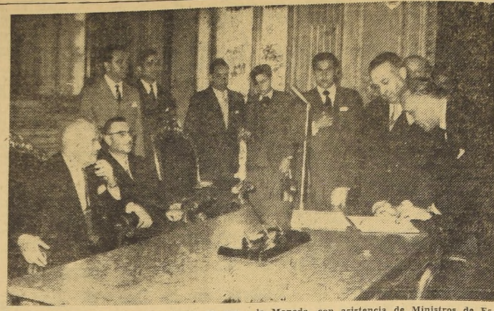
En el grabado se muestra el momento en que se procede, en presencia del Presidente de la República, a la firma del contrato entre la Empresa de los Ferrocarriles del Estado, y el Grupo Ariénde Italiano, para la electrificación del tramo ferroviario de Santiago a Chillán. La ceremonia tuvo lugar en el Salón Rojo de
