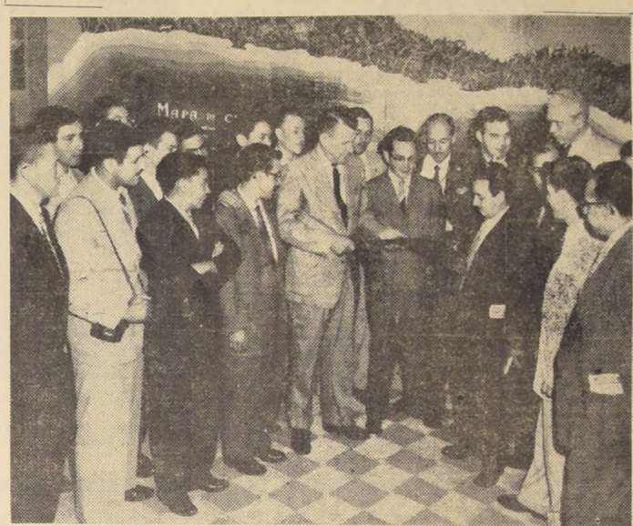
Un éxito superior a toda expectativa ha tenido la Exposición de Chile presentada en el International Trade Mart Building, de Nueva Orleans, por la Compañía Chilena de Electricidad Ltda. Miles de personas han visitado esta muestra que constituye, por todos los elementos expuestos, tal como su nombre lo indica, una perfecta "VISION DE CHILE". En la fotografía puede verse —teniendo al fondo el gran mapa en relieve proporcionado por el Instituto Geográfico Militar— a un grupo de estudiantes de Guatemala que de paso por Nueva Orleans visitaron la Exposición acompañados por el señor Curt Siegelin, Director del Departamento de Comercio e Industrias de Luisiana. El grabado los ha captado mientras observan una cimitarra, con cabeza de telmirro, hecha de madera chilena.
