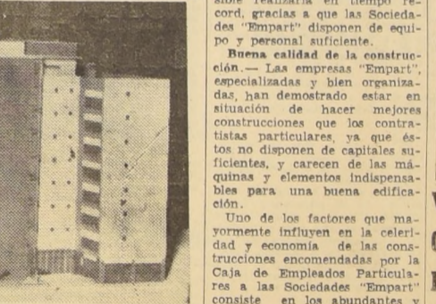
Magníficas son las proporciones del edificio "San Martín", que se levanta en Concepción. Se encuentra ya terminado y es un positivo aporte al progreso urbanístico de la gran ciudad sureña.
