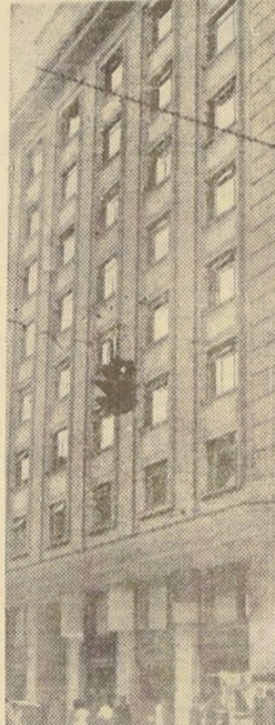
EN TEATINOS 251, junto a la Plaza de la Constitución y en su centro de Santiago, se alza este enorme edificio de departamentos para habitación, construido para entregarse como vivienda para sus imponentes. Cerca de doscientas familias ocupan los departamentos que cuentan con toda clase de comodidades modernas y de excelente distribución de su espacio. La sólida construcción y el hecho de estar próximo a la mayor de las más importantes oficinas fiscales, junto con resolver el problema habitacional de sus ocupantes, les acerca al campo hacia sus frentes de trabajo.
