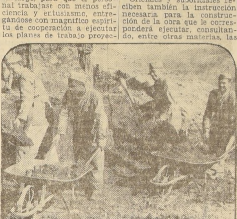
SOLDADOS EN TRABAJOS CAMINEROS DE EMERGENCIA
