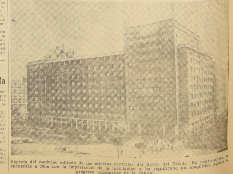
Aspecto del moderno edificio de las oficinas centrales del Banco del Estado. Su construcción se encuentra a tono con la importancia de la institución y ha significado un magnífico aporte al progreso urbanístico de la capital.
