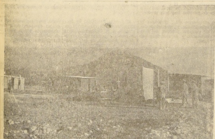
Trabajos de urbanización de la Población "Santa Lucía", de La Serena, que el Servicio Militar del Trabajo construyó en sólo 30 días de labor, con 30 casas de dos habitaciones, baño y cocina.
