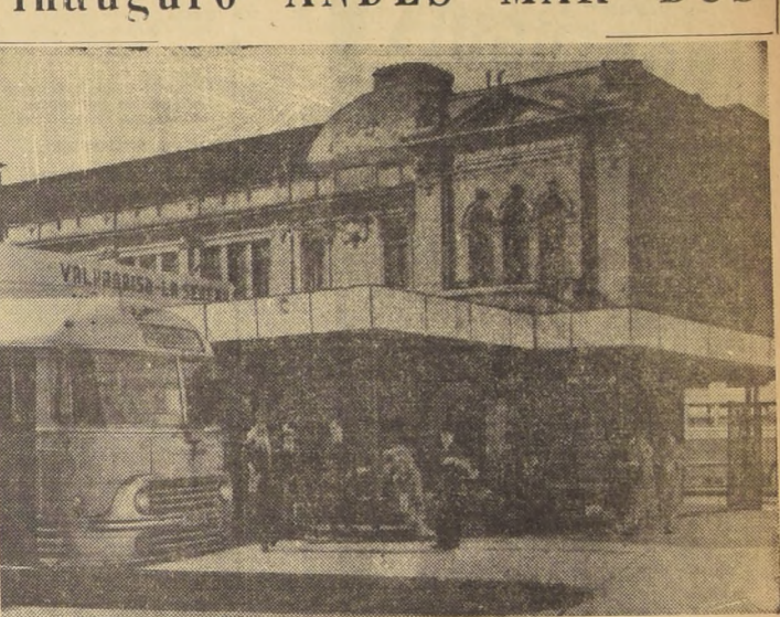
Vista parcial de la moderna estación terminal de los buses de ANDES MAR BUS.
