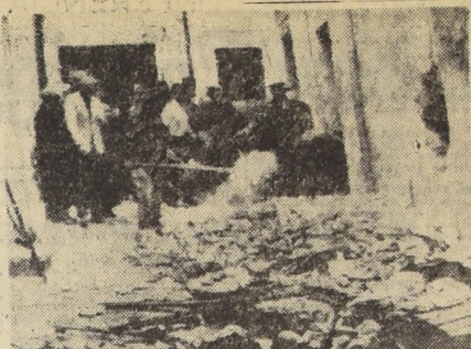
ALICORN, Sicilia.— Un grupo de trabajadores y voluntarios tratan de abrir paso entre los escombros de un edificio de escuela aquí que se derrumbó ayer. Los hombres tratan de salvar algunos niños después que un fuerte huracán voló la estructura. Alrededor de 50 niños estaban en la escuela cuando ocurrió el derrumbe. Seis niños del kindergarten perdieron la vida. Otras tres personas, inclusive el director de la escuela, también murieron.— (Radiofoto UNITED PRESS.)
