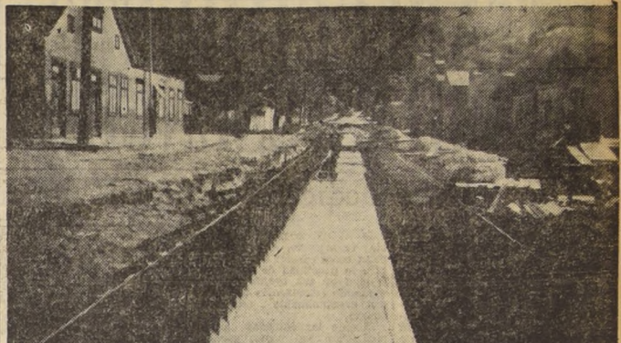
CANALIZACION DEL ESTERO "EL BOLDO" - Un aspecto de los trabajos de construcción del acueducto que hará desembocar en el mar el estero El Boldo, que atraviesa todo el plan de Corral Bajo. Enormes perjuicios causa todos los años el envenenamiento de la población. Recientemente, el Ministerio de Obras Públicas dispuso la suma de $ 25.000.000 para proseguir hasta la terminación de esta obra, que amenazaba quedar inconclusa por la falta de fondos, ya que el proyecto original debió ser modificado al construirse el molo frente al Grupo Escolar, lo que hizo aumentar el costo del nuevo cauce de hormigón. (Campos, corresponsal.)
