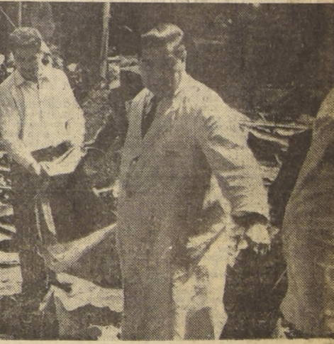
Supervigilados por personal de la Quinta Comisaría Judicial de Investigaciones, al mando del Comisario, don Benjamín Araya, obreros han sido guiados removiendo los escombros del edificio incendiado en calle Vergara esquina Alameda, en busca de nuevas víctimas. En la tarea realizada durante la mañana de ayer y parte de la tarde, se encontró el cuerpo carbonizado de la modista, Sara Hurtado Reyes, pero aún se espera encontrar el cadáver del ciudadano yugoslavo Branko Kukuljani, tornero de fama. En el grabado, durante la jornada cumplida ayer en la mañana,
