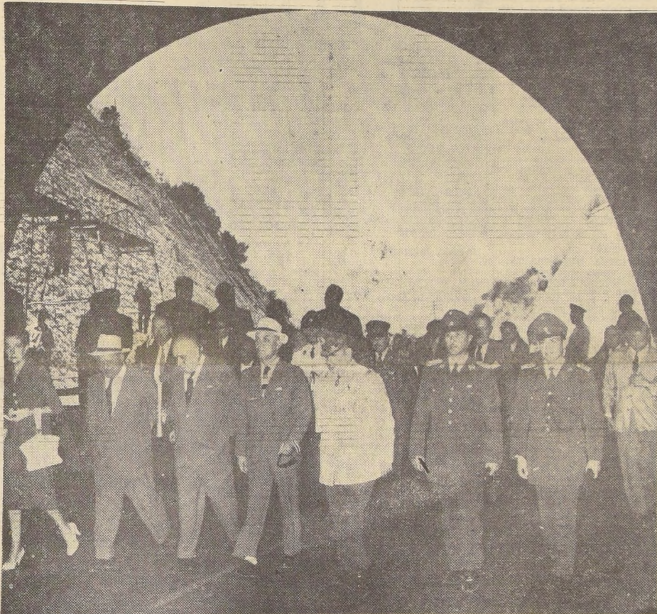
El Ministro de Obras Públicas, general Eduardo Yáñez Zavala, acompañado de altos funcionarios de esa Secretaría de Estado y de jefes y oficiales del Cuerpo de Carabineros, periodistas y representantes de la Empresa Constructora "Alfredo Campos Segovia y Cía. Ltda.", entra en el túnel de Lo Zapata, cuya recepción oficial tuvo lugar ayer al mediodía. Posteriormente, el Ministro Yáñez y los asistentes a la ceremonia, almorzaron en Curacavi.
