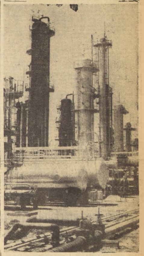
La refinería de petróleo de Concón, que será ampliada con 1700 nuevas unidades, lo que hará llegar su producción a 24 mil barriles diarios.
