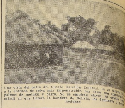
Una vista del patio del Cuartel Batallón Colonial. Es el último de la entrada de selva más impenetrable. Las casas son construidas en las palmas de motakó y barro. No se emplean clavos. Al centro del mástil en que flamea la bandera de Bolivia, los domingos y feriados.
