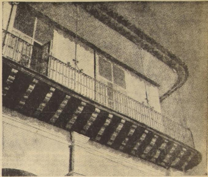
ANGULO DEL BALCON exterior del Palacio Itzaga, en Trinidad. Obsérvese la vigertería de madera dura, formando casetones; el sótfo de los aleros en escorzo; las tejas criollas, las persianas fijas en lo alto y las típicas con varilla vertical al medio; las barandas de hierro forjado, con elementos que las unen al alero, y ganchos para colgar liestos de flores o faroles. Debajo del balcón de solana, las pilasiras adosadas, con capiteles. — (Foto arquitecto Nicolás Quintana.)
