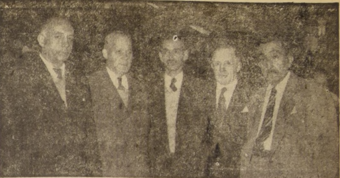
UN NUEVO ESFUERZO COOPERATIVO, se traducirá en la construcción de una población de 75 casas en la Comuna de San Bernardo...
