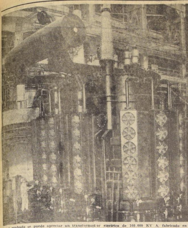
En el grabado se puede apreciar un transformador eléctrico de 160.000 KV A. fabricado en el Japon y que pone en evidencia el progreso industrial de ese país.
