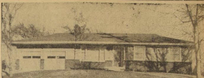
La madera, como se puede observar en este bungalow, bien utilizada da hermosos golpes de vista. El suelo es de ladrillos; pero la parte superior es toda de madera. El techo bajo, de tejas, contribuye a darle una continuidad de línea que hace el conjunto agradable.
