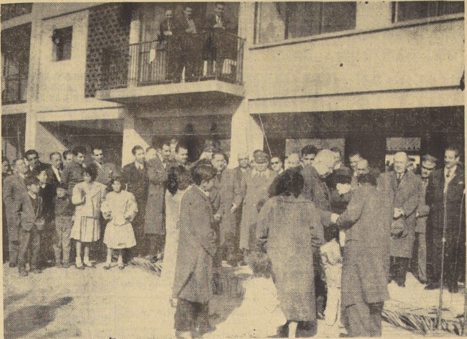
Linares y Talca testimoniaron su afecto y reconocimiento al Jefe del Estado con motivo de la inauguración de dos grupos habitacionales en esas ciudades, que fueron construidos por la Caja de Previsión de los Empleados Particulares.
