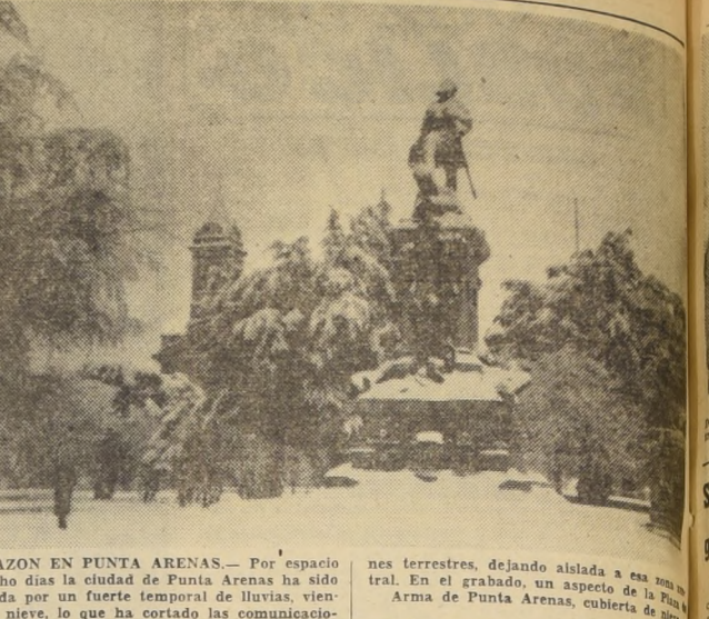
NEVAZON EN PUNTA ARENAS.— Por espacio de ocho días la ciudad de Punta Arenas ha sido azotada por un fuerte temporal de lluvias, vientos y nieve, lo que ha cortado las comunicaciones terrestres, dejando aislada a esa zona del sur. En el grabado, un aspecto de la Fuerza Armada de Punta Arenas, cubierta de nieve.
