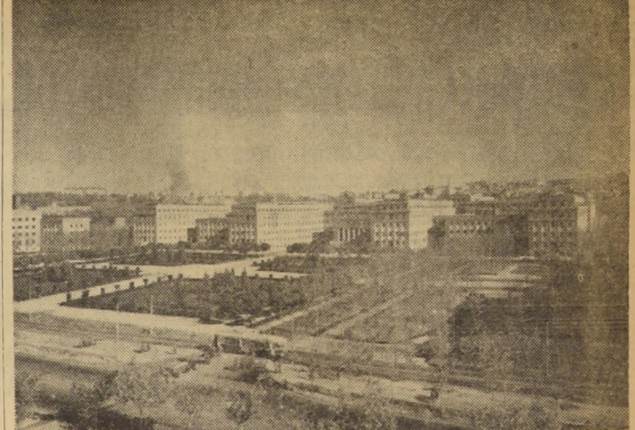
Los pabellones que albergan en la Ciudad Universitaria de Madrid la Facultad de Medicina y los servicios anejos a la misma, pueden ser considerados como el prototipo de lo que es el conjunto universitario madrileño establecido en las proximidades de Madrid. La Ciudad Universitaria ocupa una extensión de 320 hectáreas, rodeada de unos terrenos en los que nunca se podrá edificar, y por tanto, la expansión de la capital no podrá absorber ni ahogar el recinto universitario. El conjunto arquitectónico está presidido por la idea de unidad, y por ello, aunque son muchos los arquitectos que han realizado los proyectos de las distintas Facultades y Escuelas, al frente de todos ellos figura como director y orientador máximo don Modesto López Otero que en la unidad arquitectónica ha querido expresar el espíritu de unidad de la Universidad. Esta Ciudad Universitaria ha tenido que ser reconstruida después de la guerra de España, pues todos sus edificios quedaron destruidos, al ser aquel uno de los sectores del frente de Madrid en los que más duramente se combatió.
