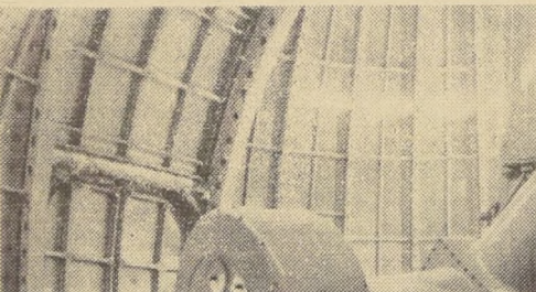
FRANCIA POSEE UN TELESCOPIO GIGANTE. — El nuevo telescopio gigante de Saint-Michel-de-Provence (nuestra foto) es el cuarto del mundo después de los de Monte Palomar, Wilson y MacDonald. Su espejo parabólico, de 1,93 m. de diámetro y de un peso de 1.200 kg., fue fundido por las fábricas de Saint-Gobain. Una cúpula giratoria, tan grande como la del Pantheon de París, alberga el telescopio gigante, cuya cámara electrónica permite estudiar estrellas situadas a más de 500 años-luz de nuestro planeta. (Foto SFL.)
