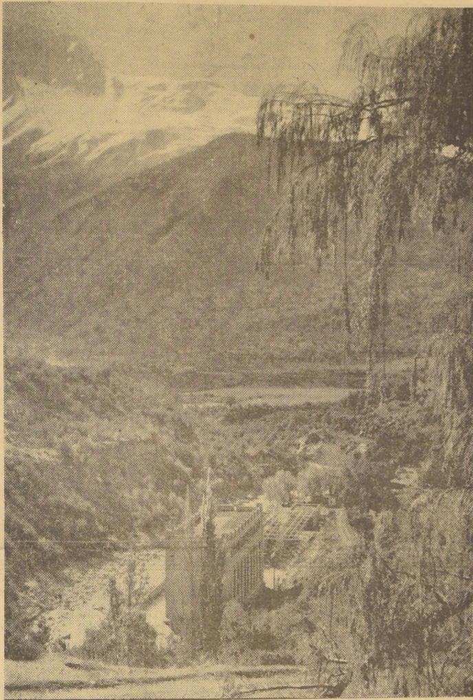
La Planta Eléctrica de Los Queltehues, que ha quedado fuera de servicio debido a la aguda crisis sísmica que sacude la región. Este accidente determinará un racionamiento extraordinario en el suministro de energía eléctrica. El informe del Instituto Sismológico de Chile establece que no hay aún indicios de que este fenómeno tenga origen volcánico. Los temblores han continuado en toda la zona. El epicentro estaría ubicado, precisamente, en la laguna que alimenta esta Planta. También ha sido seriamente afectada la Planta de El Volcán.
