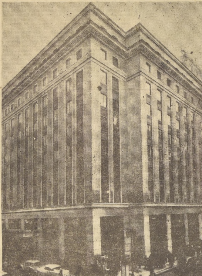
SEDE principal del Instituto de Seguros del Estado, ubicada en la intersección de las calles Ahumada y Moneda, esquina surponiente, de la capital.
