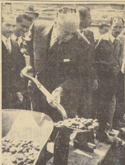
PRIMERA PALADA.— Walter Howe, Embajador de los Estados Unidos en Santiago, da la primera palada, en la mañana de ayer, al inaugurarse los trabajos de autoconstrucción de 216 viviendas para familias modestas. A su izquierda el gerente general de la CORVI, Hernán Lavanderos y a su derecha, dirigentes de los pobladores de "La Palma". Estas casas se levantarán con fondos provenientes de los Excedentes Agrícolas y de los acuerdos con el Instituto de Cooperación Interamericano.
