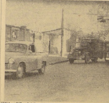
UNA DE LAS "GARGANTAS".— El grabado muestra la "garganta" de tránsito que se forma en uno de los umbrales de la capital. Por esta ruta se llega a Puente Alto, caminando hacia el sur. Todavía cuelgan de los alambres los restos de una ilusión electoral. Observe el atascamiento de vehículos en Franklin con Santa Elena. La estrechez de la calzada es una grave dificultad para el paso de los grandes buses de la ETCE y, además, no existe control de ninguna naturaleza. (INFORMACION, PAGINA 7)
