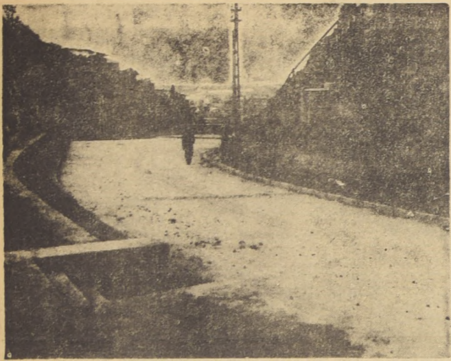
SUBIDA LAS CARAS. — La Subida Las Caras, única vía de acceso a este populoso cerro, es una de las obras de mayor envergadura que se han ejecutado este año, y cuya entrega oficial se realizará el viernes. En esta vía de acceso, cuya extensión es de 600 metros, se han invertido cerca de 50 millones de pesos. Además se tienen los estudios para la continuación, hasta la Avenida Alemana.
