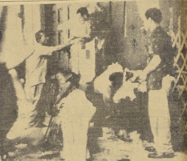
LA HABANA.— Varias personas aparecen registrando los escombros de una ventana de un establecimiento comercial que fue destruido durante los incidentes producidos en esta capital. (Radiofoto UPI.)
