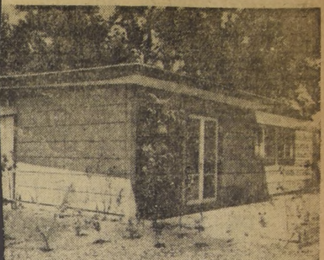
Construcción con el sistema Hellenit. Es, se puede decir, tipo Ley Perel. El periodo de construcción es de sólo 90 días y su costo baja en un 30 por ciento al sistema tradicional. Tiene 100 metros cuadrados.
