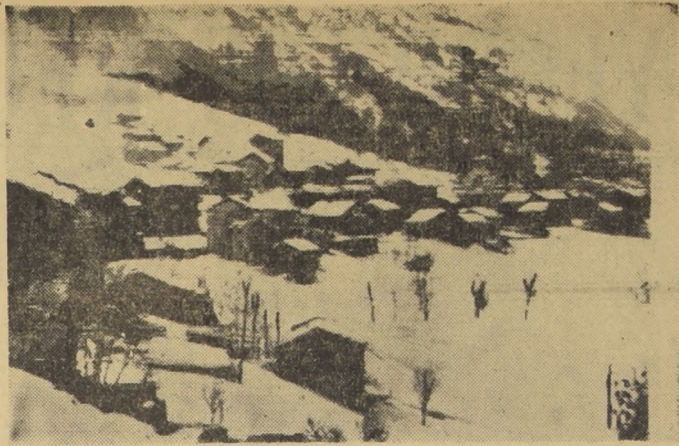
HERRRIGEN, Suiza. — Esta desierta aldea espera un posible destrucción de parte de un alud de tierra y nieve de enormes proporciones que la amenaza desde una montaña a 4.000 pies sobre la aldea. Los 215 habitantes han sido evacuados.
