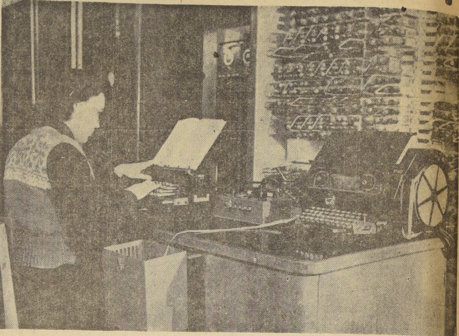
MAQUINA RUSA. — Un prototipo soviético de máquina de traducir ha comenzado ya su funcionamiento experimental. La mecanografía copia el libro en signos inteligibles para el cerebro electrónico. Este, en el teletipo de la derecha, da como resultado la traducción impresa en una cinta continua.
