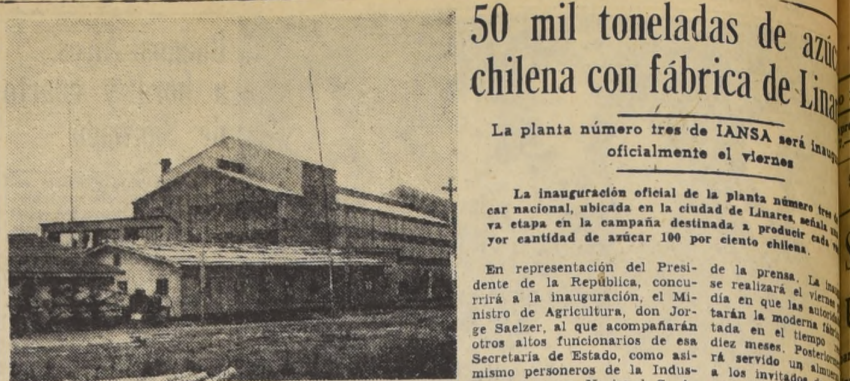
FABRICA DE AZUCAR.— Aspecto general de la fábrica número 3, de azúcar, cuya inauguración en Linera se efectuará oficialmente el próximo viernes, con asistencia del Ministro de Agricultura, y otras autoridades.
