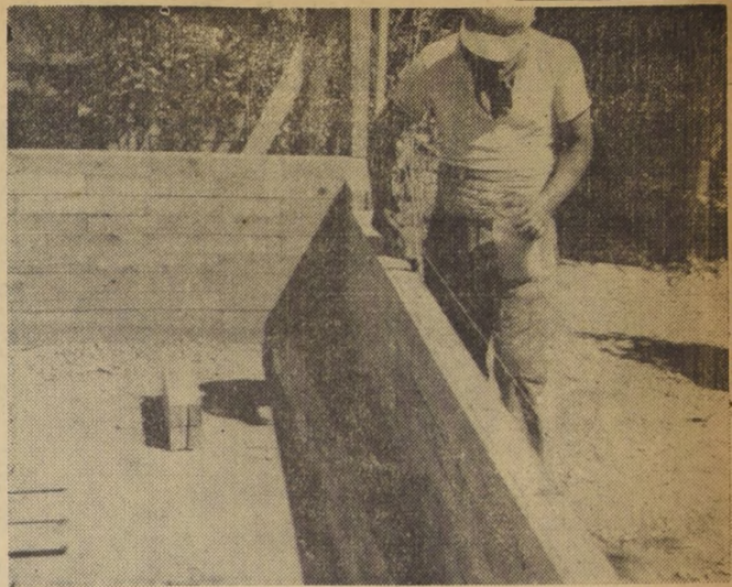
En el sistema de bloques de madera no se necesita ser obrero constructor ni especializado. El grabado explica cómo se colocan. Este propietario pone sobre la hilada de bloques un brochazo de cola plástica, con catalizador.
