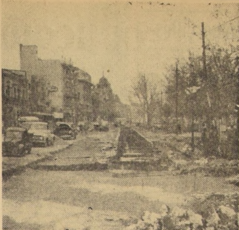
En el grabado, un aspecto de los trabajos que realiza por Administración, la Dirección de Pavimentación de Santiago, después de resolver el contrato a la firma que los estaba ejecutando en la calle norte de la Alameda Bernardo O'Higgins, en el tramo comprendido entre Testinos y Avenida Cumming.
