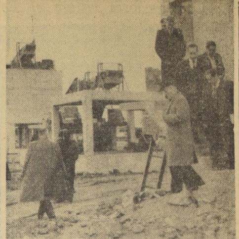
El Intendente-Alcalde, regidores y periodistas, recorren las diversas instalaciones de la planta de asfalto que la Municipalidad construye en su chacra Lo Ruiz, durante la visita realizada ayer.
