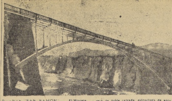
PUNTE "SAN RAMON".— El Ministerio de Obras Públicas ha aceptado la propuesta presentada por la firma Yaconi Hermanos, S.A., para la construcción del puente "San Ramon", en el camino de Puento Alto a Pirque. Esta obra tendrá un costo de $ 64.717.700.
