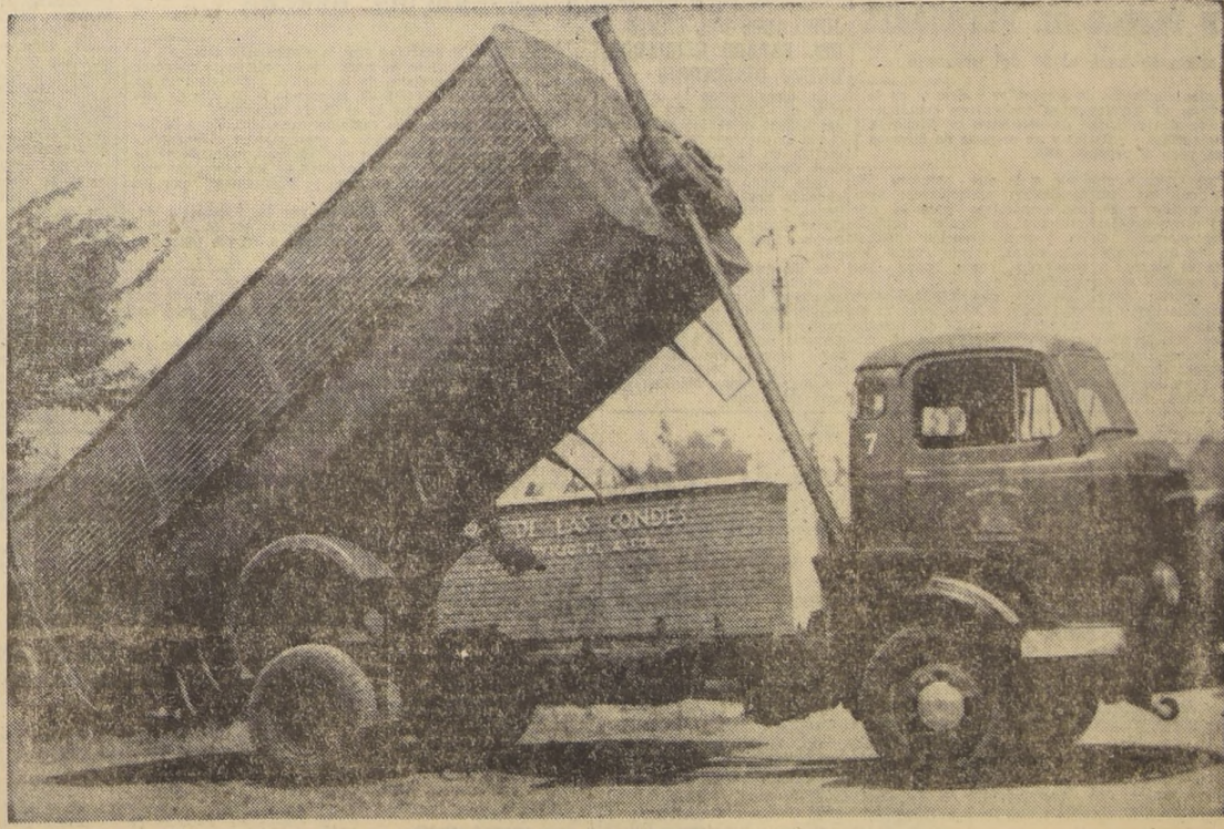
Recolector de basura KARRIER DERBY, tipo Municipalidad de Las Condes, con capacidad para 16 yardas cúbicas, o sea, 12,25 metros cúbicos, montado en chasis Gamecock de 91 H. P. Se bota la basura por la puerta trasera y no hay mecanismo en la tolva.
