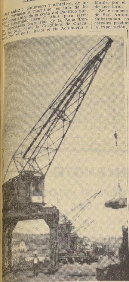
GRUAS PARA TODO TRABAJO.— Una de las grúas de puerto de San Antonio, en plena faena. Cuenta con más de una docena de estas grúas de plumas fijas y móviles, capacidad para tres mil kilos cada una; una grúa a vapor para 13 mil kilos; ocho grúas eléctricas para 1.500 kilos y otras grúas automóbiles y atochadoras
